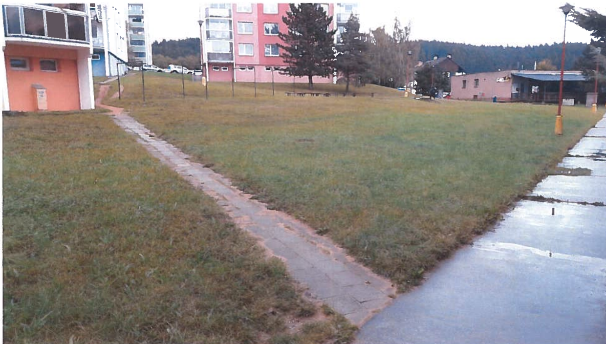
stávající stav spojovacího chodníku vnitrobloku bytových domů
