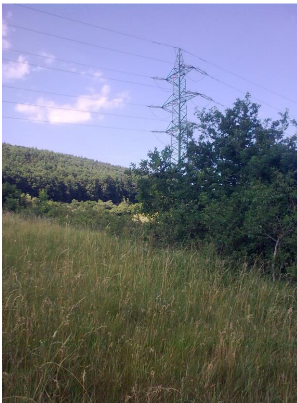
POHLED DO SEVERNÍ ČÁSTI LOKALITY LIMITOVANÉ VEDENÍM VVN
